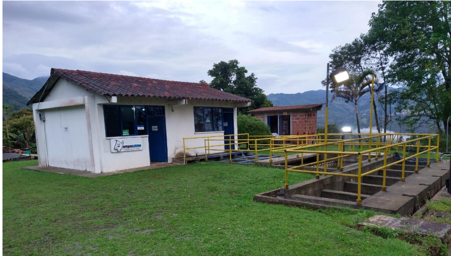
ESTADO ACTUAL PLANTA DE TRATAMIENTO DEL MUNICIPIO DE MARMATO EMPOCALDAS S.A E.SP
