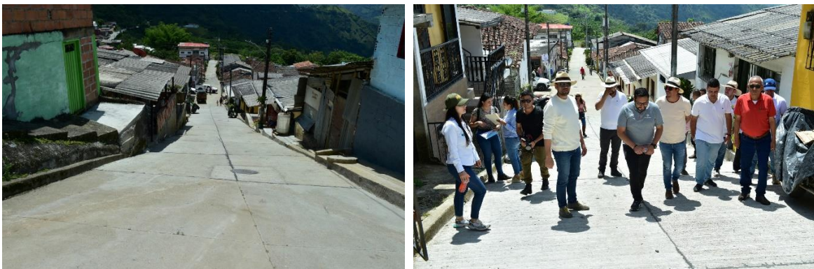
Obra de reposición de alcantarillado y pavimento en la Carrera 8 entre Calles 3 y 4
