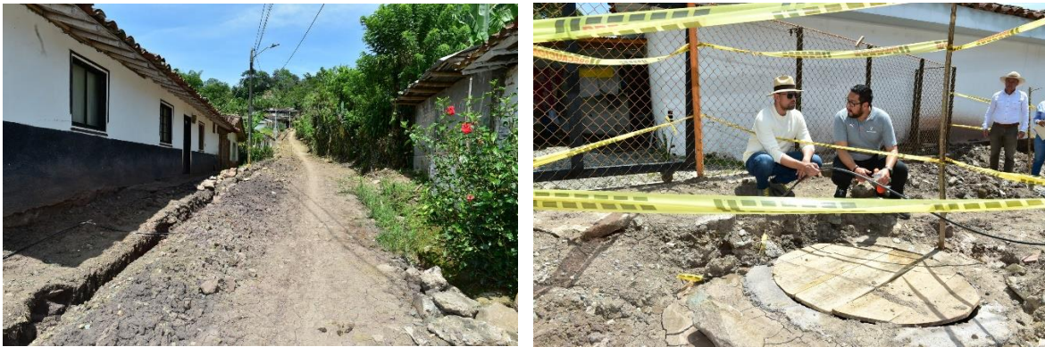
Obra de reposición de redes de acueducto y alcantarillado en el Sector Arenales
