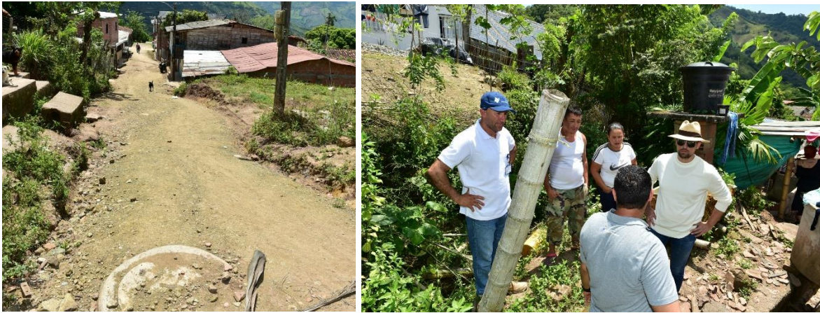
Obra de reposición de redes de acueducto y alcantarillado en el Sector Meleguindo
