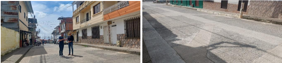
Estado de la obra realizada en la Calle 5 entre Carreras 7 y 8
