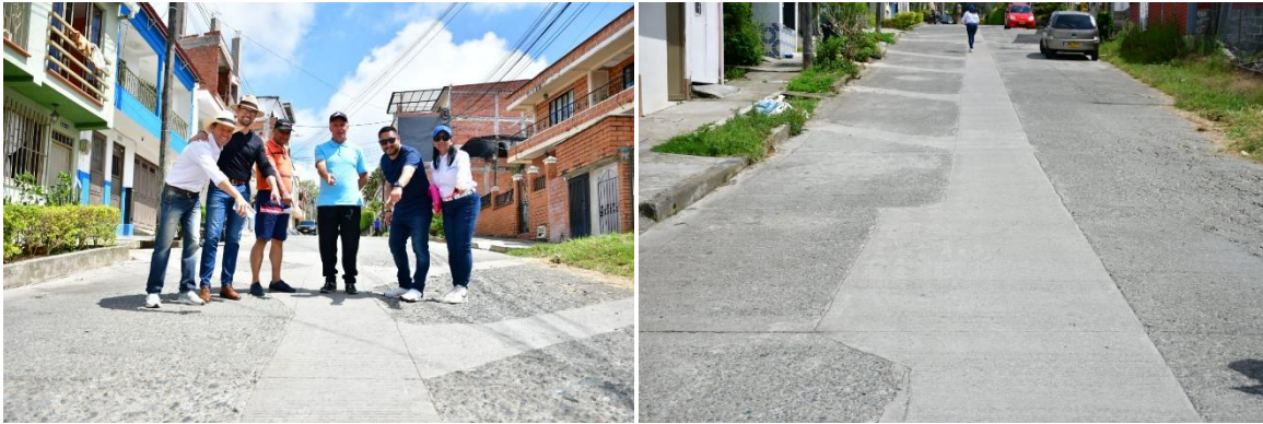
Obra de reposición de alcantarillado en la Carrera 5D entre Calles 19 y 21 del Barrio Villa Pinares
