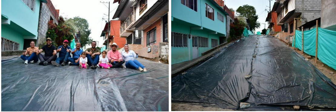
Obra en ejecución Calle 10 entre Carreras 3 y 4, Sector Estadio
