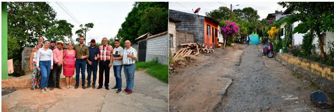
Obra en ejecución Calle 12 entre Carreras 3 y 4, Barrio Buenos Aires
