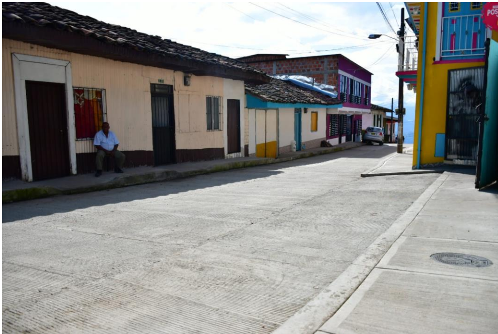
Panorámica de la obra del sector Barrio El Noventa
