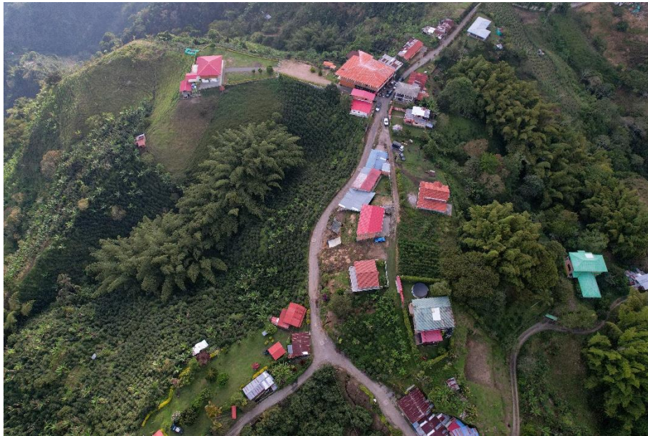
panorámica de la obra de red de alcantarillado sector vereda Alegrías en Marquetalia
