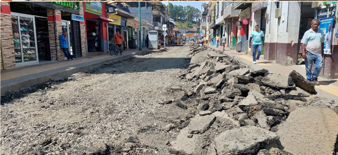
Panorámica de obra en la Carrera 2 entre Calles 1 y 7
