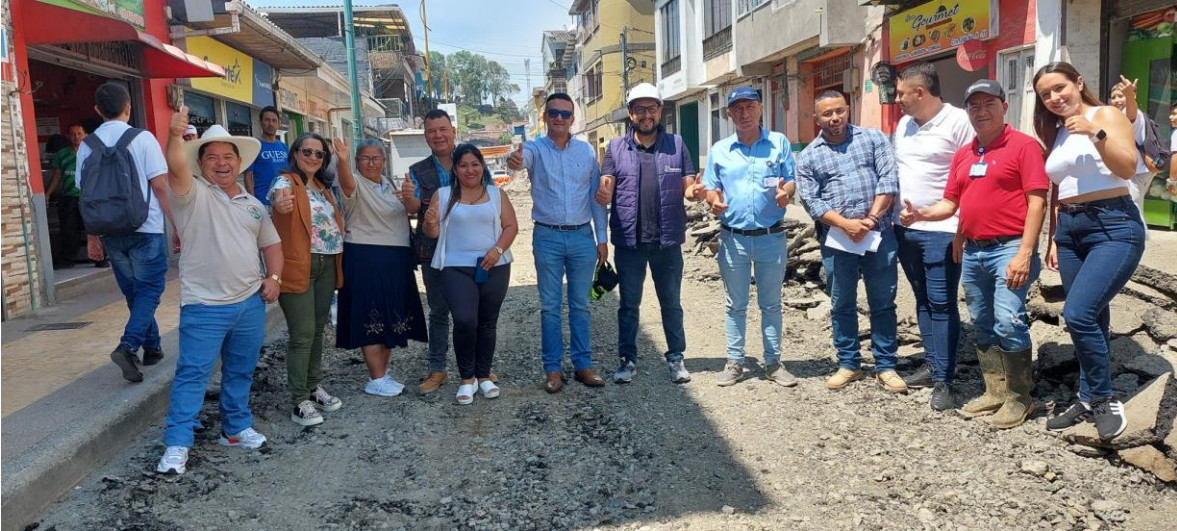
Seguimiento de Obra en la Carrera 2, vía principal de Risaralda
