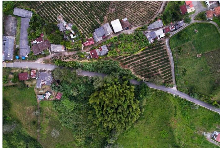
Panorámica de la obra de ampliación del acueducto Vereda La Plata, 7Km
