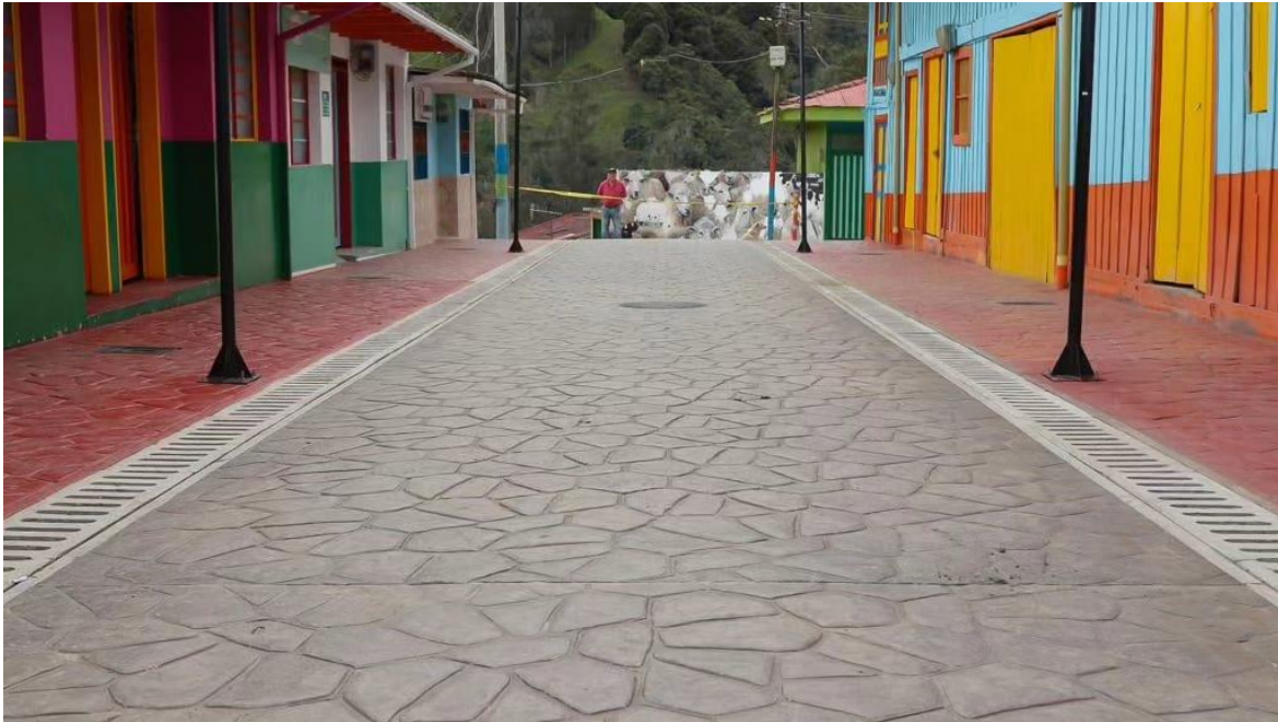
Panorámica de la obra del sector Calle del Comercio Carrera 6 entre Calles 7 y 8
