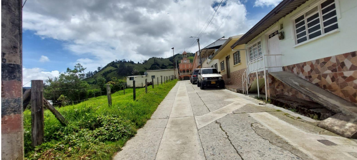
Panorámica de las obras de los sectores Carreras 4, 5 y 5Bis
