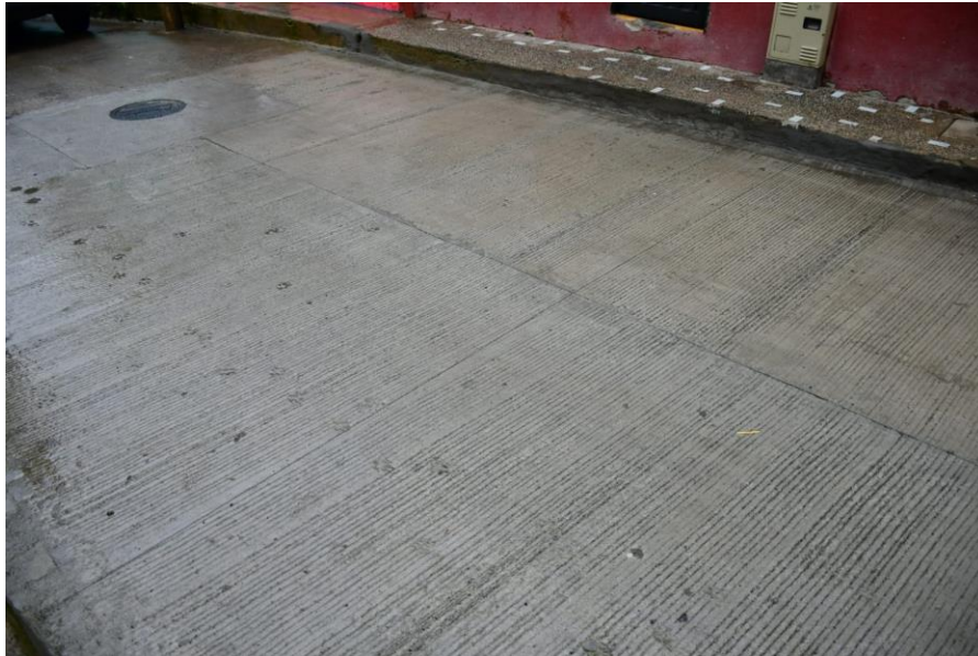
Panorámica de la obra del sector Barrio Pablo Sexto Carrera 2 entre Calles 6 y 7
