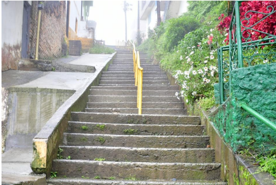
Panorámica de la obra del sector Hospital San Vicente de Paúl
