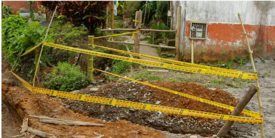
Panorámica de la obra de ampliación de la red de acueducto Vereda Alegrías – Sector Balcones
