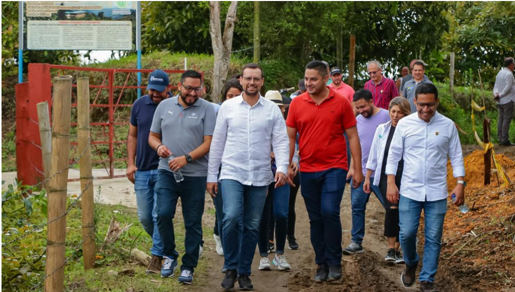
Gobernador de Caldas, Luis Carlos Velásquez, en compañía del Gerente de Empocaldas, Andrés Felipe Taba, autoridades departamentales y locales recorriendo obras en Marquetalia
