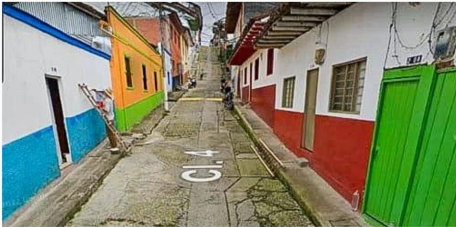
Panorámica de la obra de reposición de redes de acueducto y pavimentación de la vía en la Calle 4 entre Carreras 2 y 3 del Barrio Obrero
