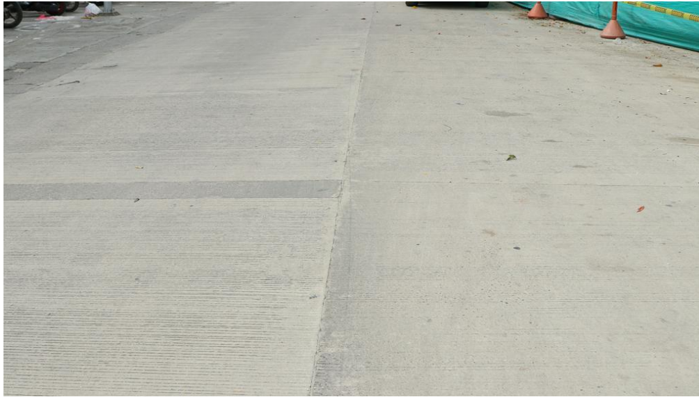
Panorámica de la obra de reposición de redes de alcantarillado y pavimentación de la vía en la Carrera 2 entre Calles 13 y 14 del Sector Parque Gaitán
