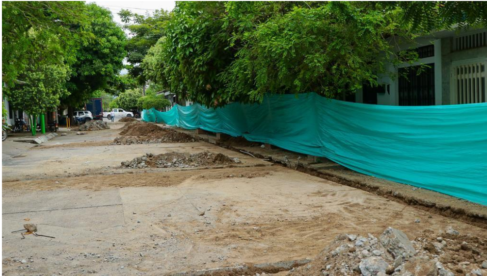
Panorámica de la obra de reposición de red de acueducto de la vía Carrera 8 entre Calles 11 a 13
