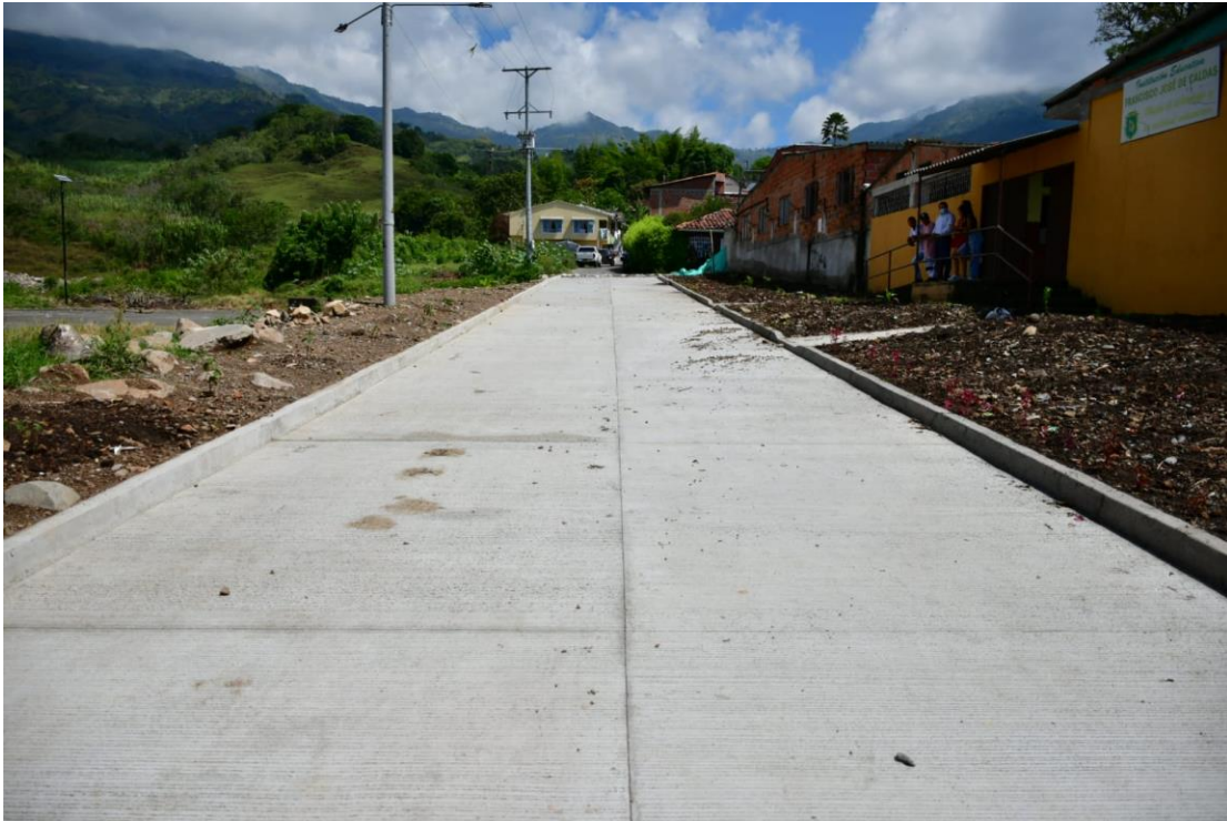
Panorámica de la obra de reposición de redes de acueducto, alcantarillado y pavimentación de la vía en la Calle 37 entre Carreras 10 a 11 y Carrera 11 entre Calles 37 a 38 del Sector INTEC
