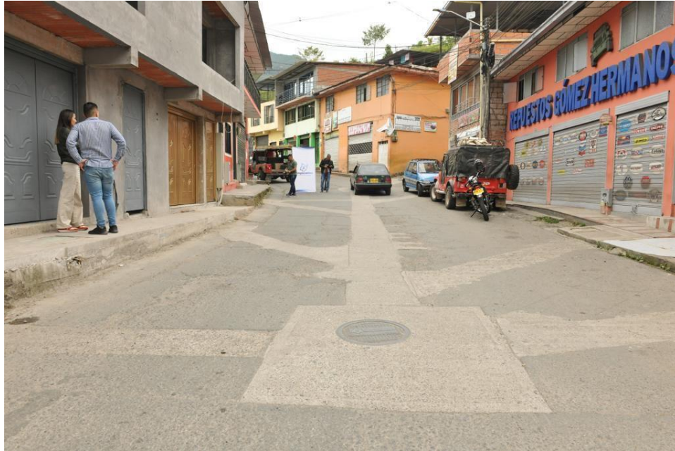
Panorámica del antiguo sector de La Cárcel de Manizales, donde intervenimos con una reposición de redes de acueducto y alcantarillado por $ 98.214.223
