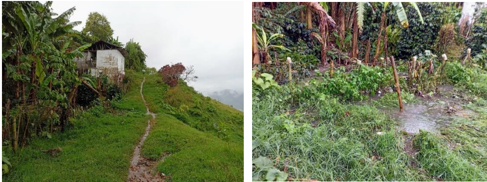
ESTADO ACTUAL DEL ALCANTARILLADO Y SECTOR AFECTADO MUNICIPIO DE ANSERMA, CALDAS
