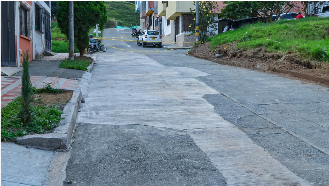
Panorámica de la obra de optimización de alcantarillado en la Calle 17A entre Carreras 5B y 5C
