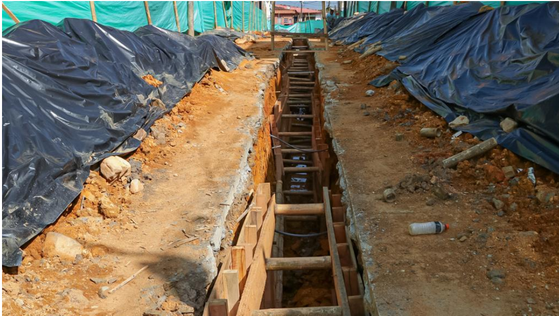
Panorámica de la obra de reposición de redes de acueducto y alcantarillado en la Calle 5 entre Carreras 7 y 8
